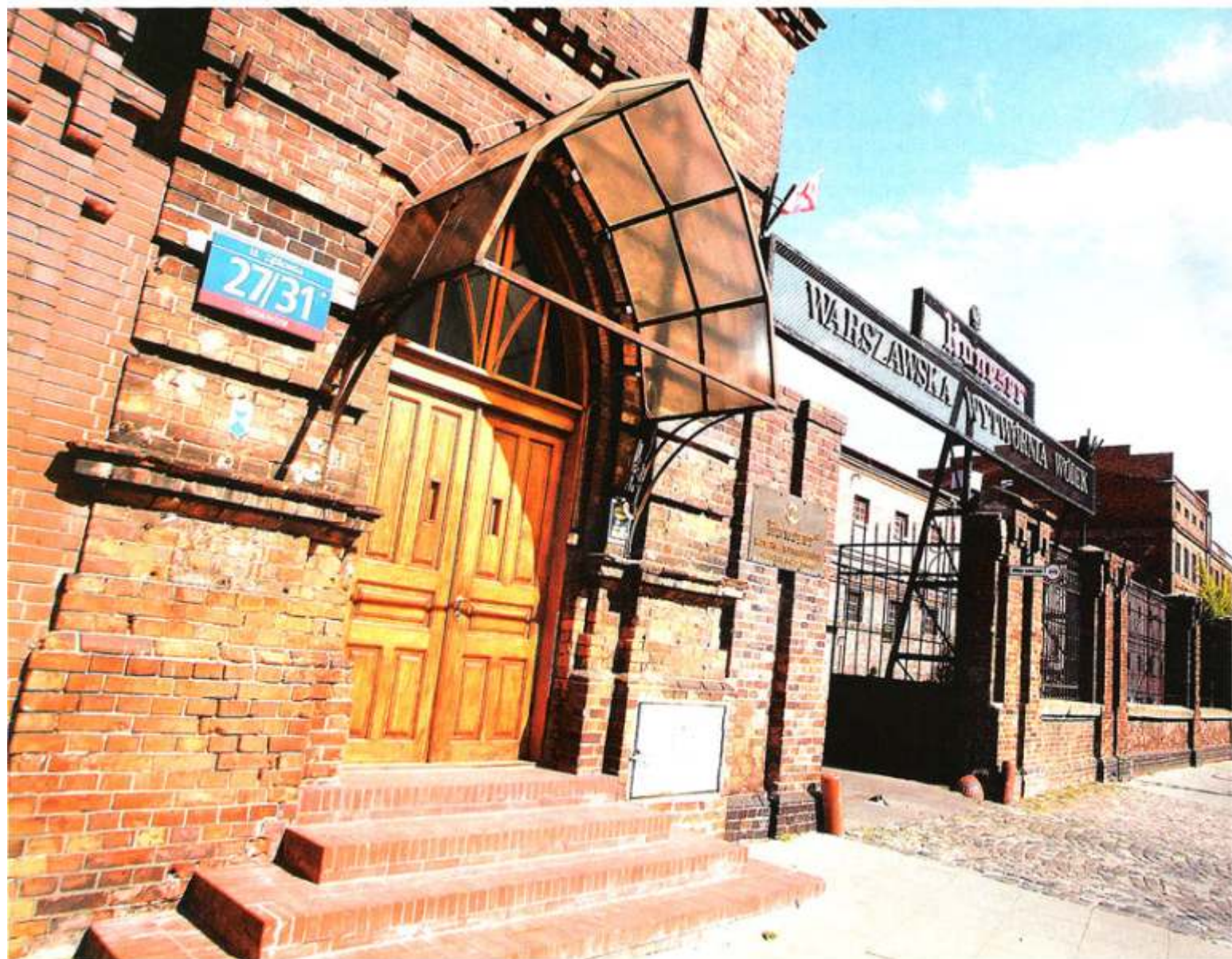
Lofty na Pradze. Już wkrótce luksusowe apartamenty powstaną również w zabytkowych murach dawnej warszawskiej Wytwórni Wódek Koneser.
